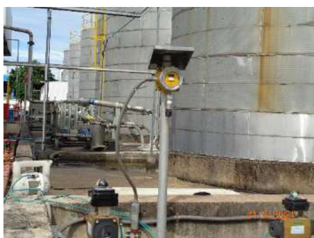
ภาพที่ 2.1-31 ระบบตรวจจับสน้ำมันของฟอรัลดีไฮด์ (Fixed Gas Detector)
