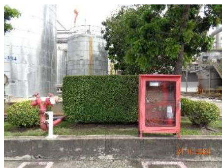
ภาพที่ 2.1-34 ระบบดับเพลิงบริเวณคันคอนกรีตรอบ ถังเก็บฟอรัลดีไฮด์
