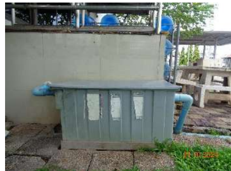
ภาพที่ 2.1-7 ระบบ SATs และบ่อดักไขมัน
