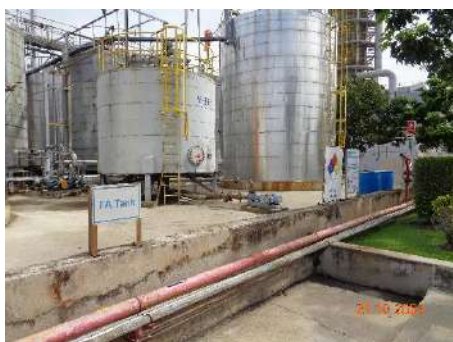
ภาพที่ 2.1-33 คันคอนกรีตล้อมรอบถังเก็บฟอรัลดีไฮด์
