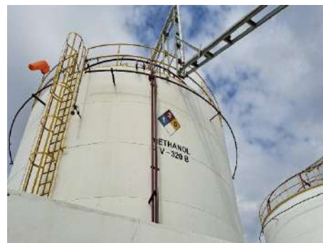
ระบบน้ำ sprinkler บริเวณถังเก็บเมทานอลมีโฟมดับเพลิง
