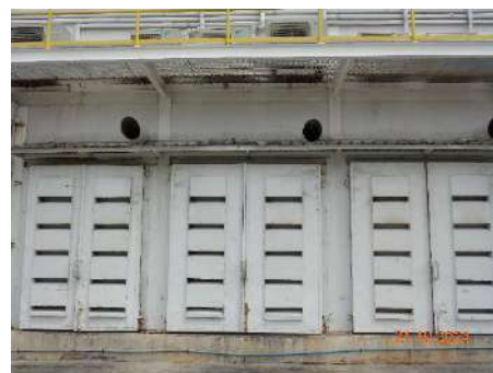
ภาพที่ 3.2.11-1 วัสดุบุรองและห้องครอบ/ฝาครอบ เครื่องจักรที่มีเสียง
