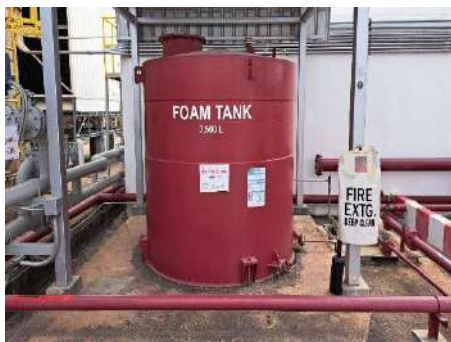
ระบบน้ำ sprinkler บริเวณถังเก็บเมทานอลมีโฟมดับเพลิง
