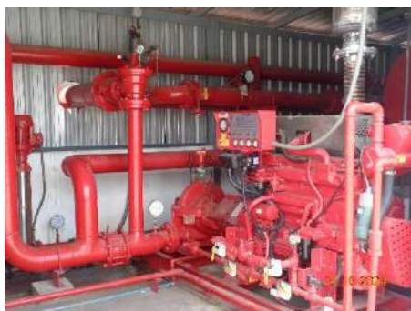
ภาพที่ 2.1-24 ระบบปั้มดับเพลิง
