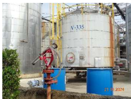
ภาพที่ 2.1-32 Fixed Foam Monitor บริเวณถังเก็บฟอรัลดีไฮด์
