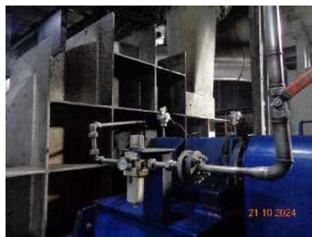
ภาพที่ 2.1-30 การติดตั้งกล่องวงจรปิดและอุปกรณ์วัดความดัน ภายในห้องเครื่องเป่าอากาศ (Blower Room)
