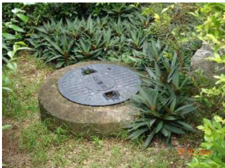
ภาพที่ 2.1-7 ระบบ SATs และบ่อดักไขมัน
